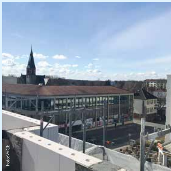
Ganz oben angekommen – Blick von der Baustelle Friedrichstraße 56/57
