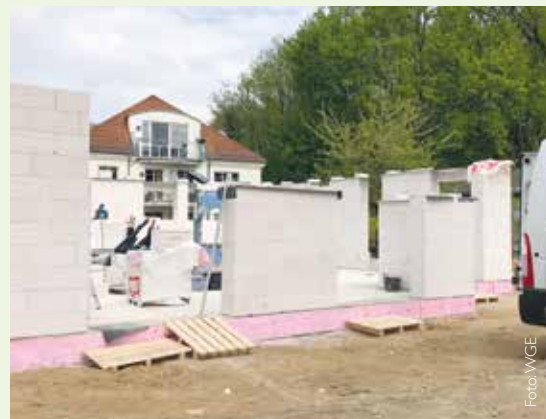
Jede Fläche zählt – Neubauvorhaben Eichhörnchenweg I auf dem Hof des Forsthauses
