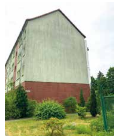
Ansicht: Fassade Berliner Straße
