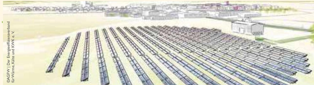
Fernwärme kann aus erneuerbaren Energien gewonnen werden. Hier ist dargestellt, wie Wasser in einer Solarthermieanlage erhitzt und in das Netz eingespeist wird.
