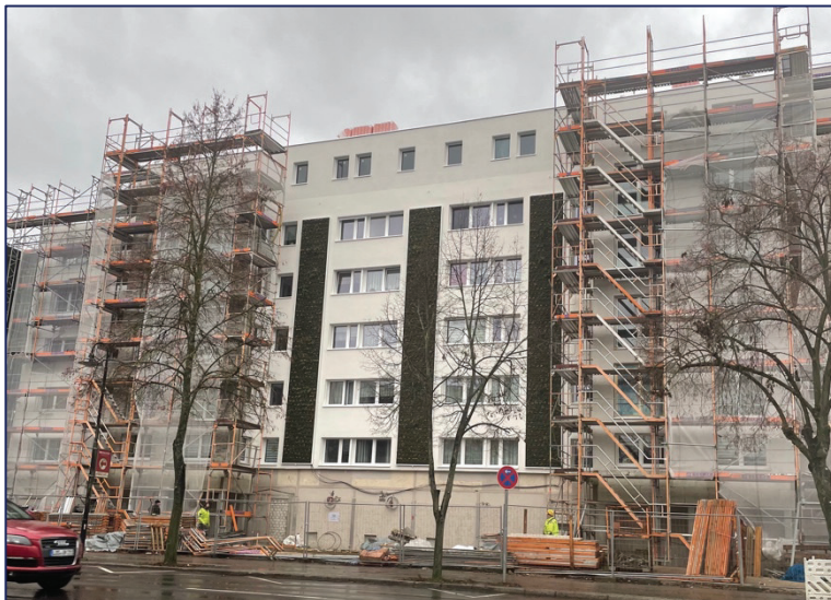
Abbildung: Stand Baustelle Begrünung 01/2024
