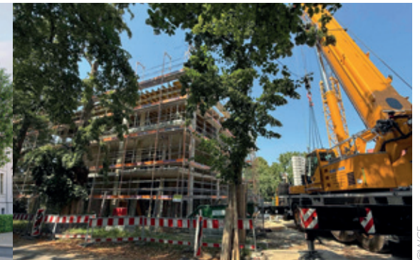
Baufortschritt 2025: Gartenstraße 1b mit Mobilkran
