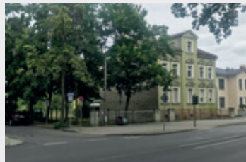
Ansicht vorher: Friedrichstraße Ecke Gartenstraße
